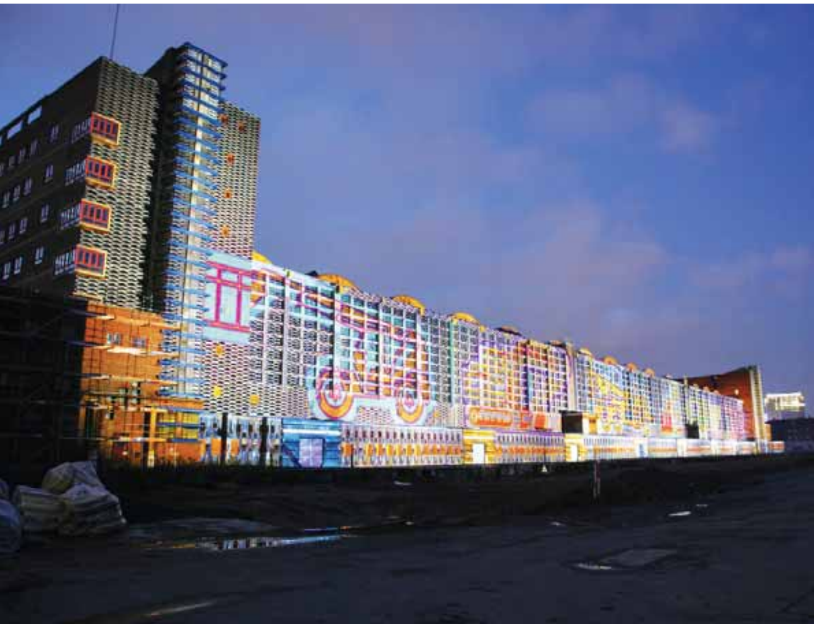
A Luminale 2008 idején a Casa Magica világítástervező művészei kivilágították a Grossmarkthallét. A kép három motívum közül a másodikat mutatja. Ez az EKB új épületének közelgő építési munkáira utalt.
