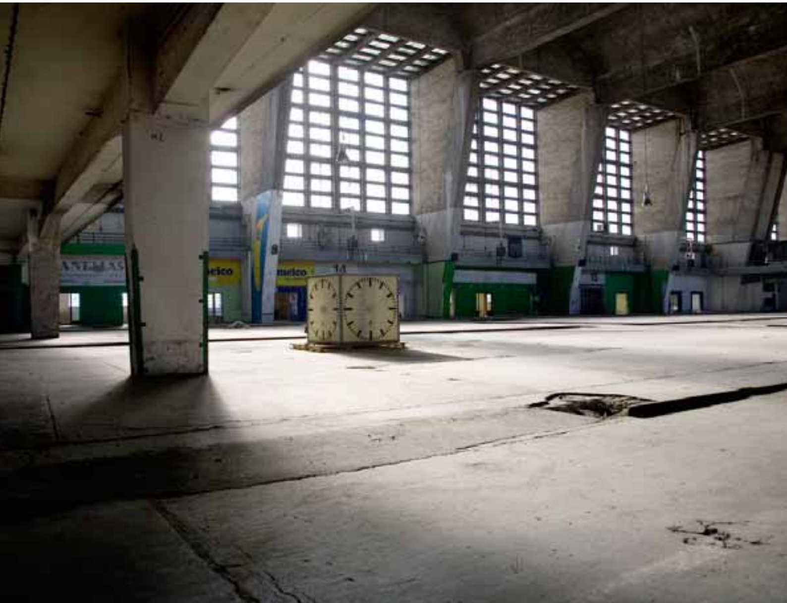
Wnętrze zabytkowej hali targowej Grossmarkthalle, (luty 2008). Budynek hali targowej Grossmarkthalle, zaprojektowany przez Martina Elsaessera, w roku 1928 (rok ukończenia budowy) był największą na świecie bezpodporową konstrukcją żelbetową.
