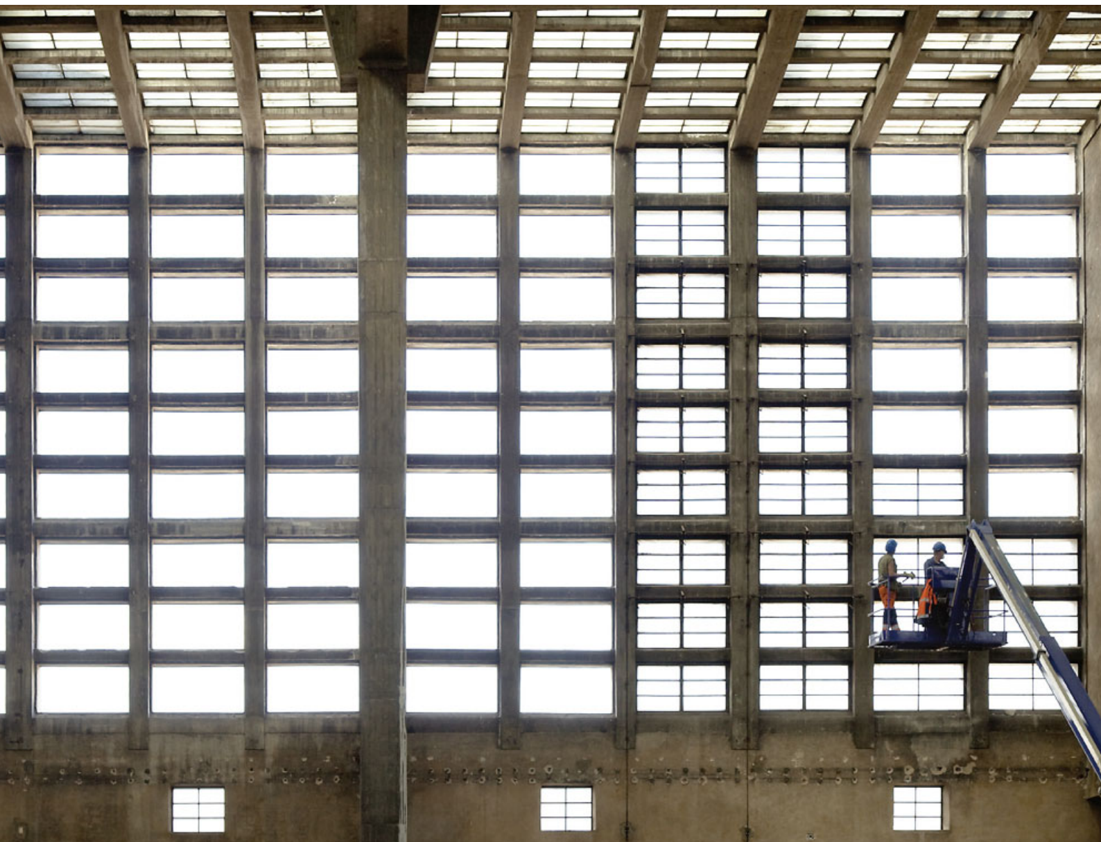
Innenansicht der Betonrasterfassade der Großmarkthalle. Die Sanierung der Großmarkthalle ist ein wichtiger Bestandteil der Bauarbeiten. Das grundlegende Erscheinungsbild des Gebäudes bleibt erhalten; die Fassaden und Oberflächen werden gemäß den geltenden Denkmalschutzaufgaben saniert.
