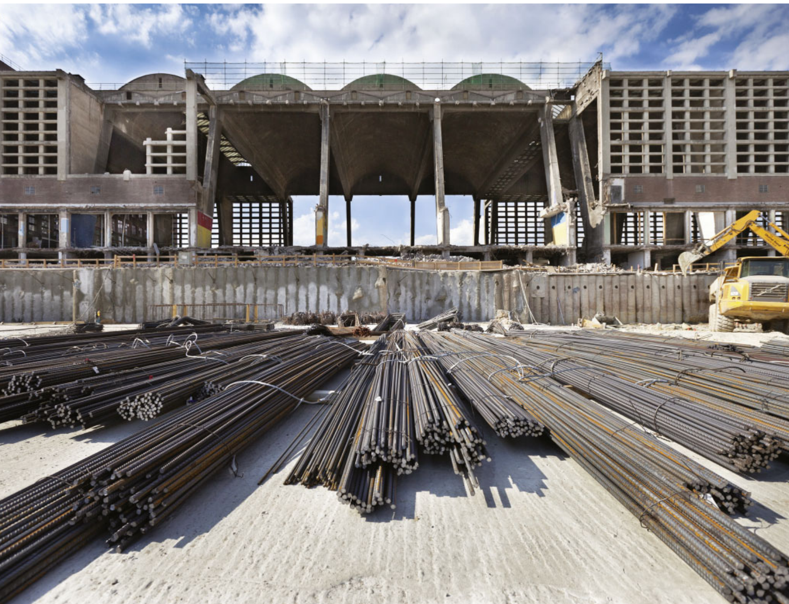
Die Bodenplatte des Doppel-Büroturms ist etwa drei Meter dick. Zur Armierung wurden rund 4 200 Tonnen Stahl benötigt.
