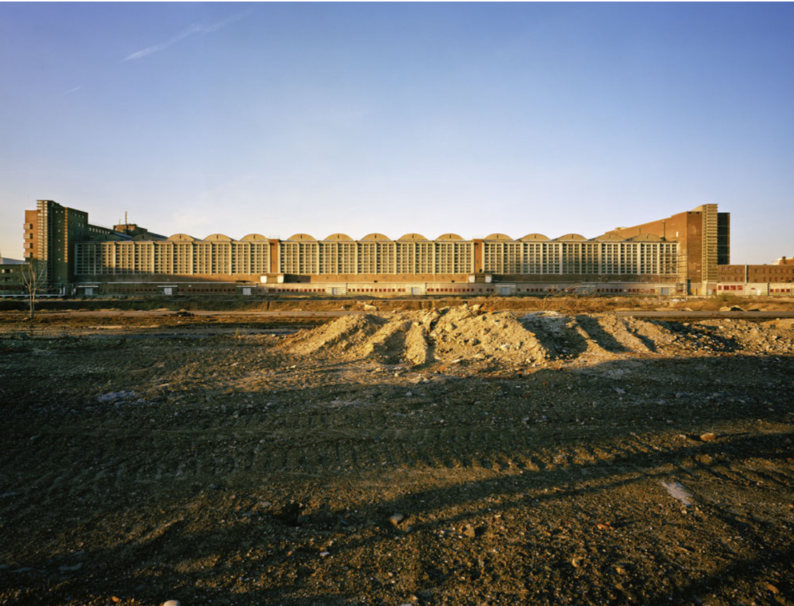
Südansicht der Großmarkthalle vor Beginn der Hauptbaumaßnahmen. Die denkmalgeschützte Großmarkthalle, in der früher Obst und Gemüse gehandelt wurden, entstand zwischen 1926 und 1928 nach einem Entwurf von Professor Martin Elsaesser.
