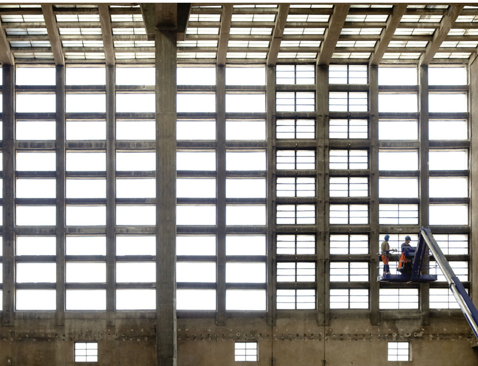
Grossmarkthallen kunnostamiseen uhrataan paljon työtä. Rakennuksen ulkoasu säilytetään olennaisilta osiltaan, ja pinnat ja julkisivut entisöidään suojelumääräyksen mukaisesti. Kuvassa julkisivun betoniristikkoa rakennuksen sisältä nähtynä.
