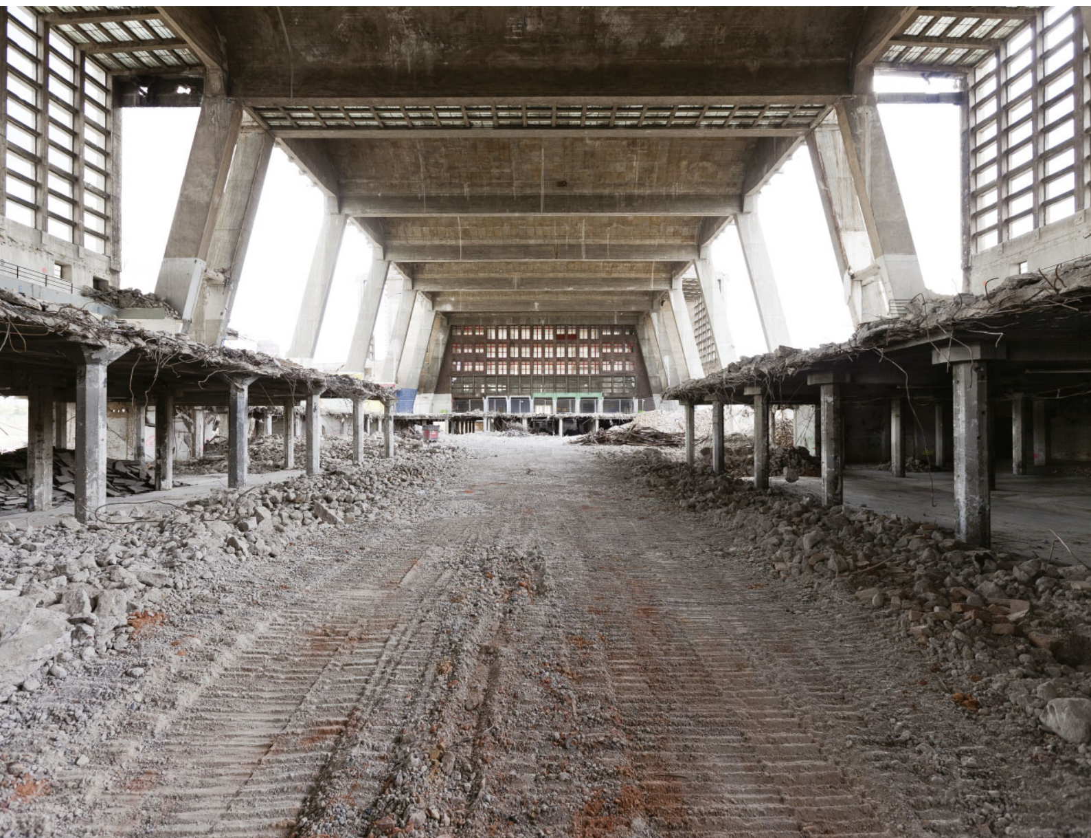
Grossmarkthalleen suunnitellut vierailijatilat, henkilöstön ruokala, kahvio ja konferenssitilat muodostavat hallin sisään itsenäisiä rakennelmia. Niitä kantamaan tarvittiin hallin sisään uusi, vahvempi rakenneratkaisu. Alkuperäinen lattia ja sen tukirakenteet purettiin vuonna 2010.
