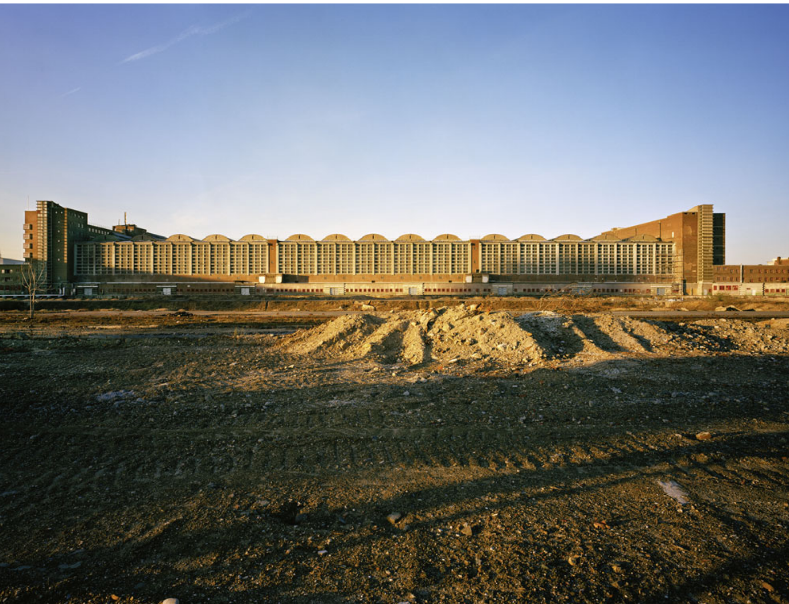
Grossmarkthalle toimi ennen hedelmä- ja vihannestukkukaupan keskuksena. Nykyään rakennus on suojeltu. Sen on suunnitellut Martin Elsaesser, ja se rakennettiin vuosina 1926–1928. Kuvassa näkymä etelästä ennen rakennustöiden alkua.
