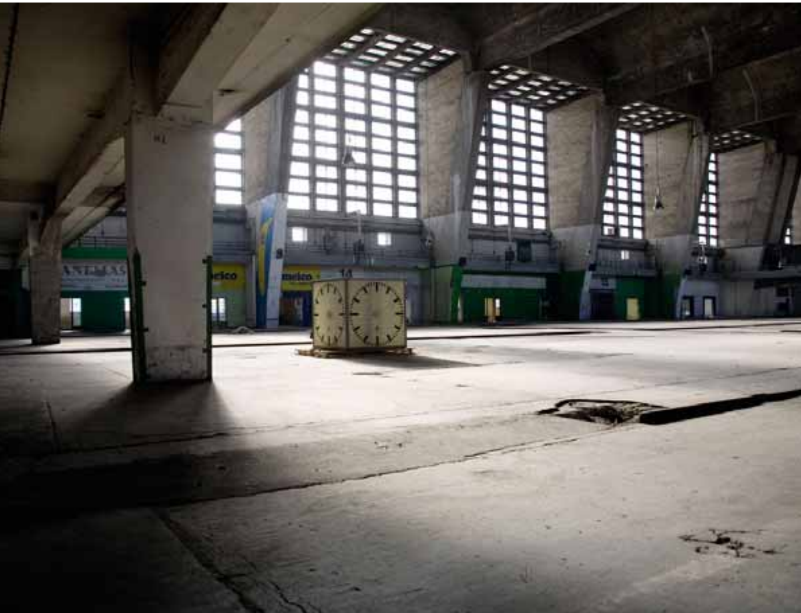
Vista degli interni della Grossmarkthalle, edificio protetto che ospitava i vecchi mercati generali (febbraio 2008). Al momento del suo completamento nel 1928, la Grossmarkthalle, progettata da Martin Elsaesser, era la più grande struttura al mondo in cemento armato a travatura di grande luce.
