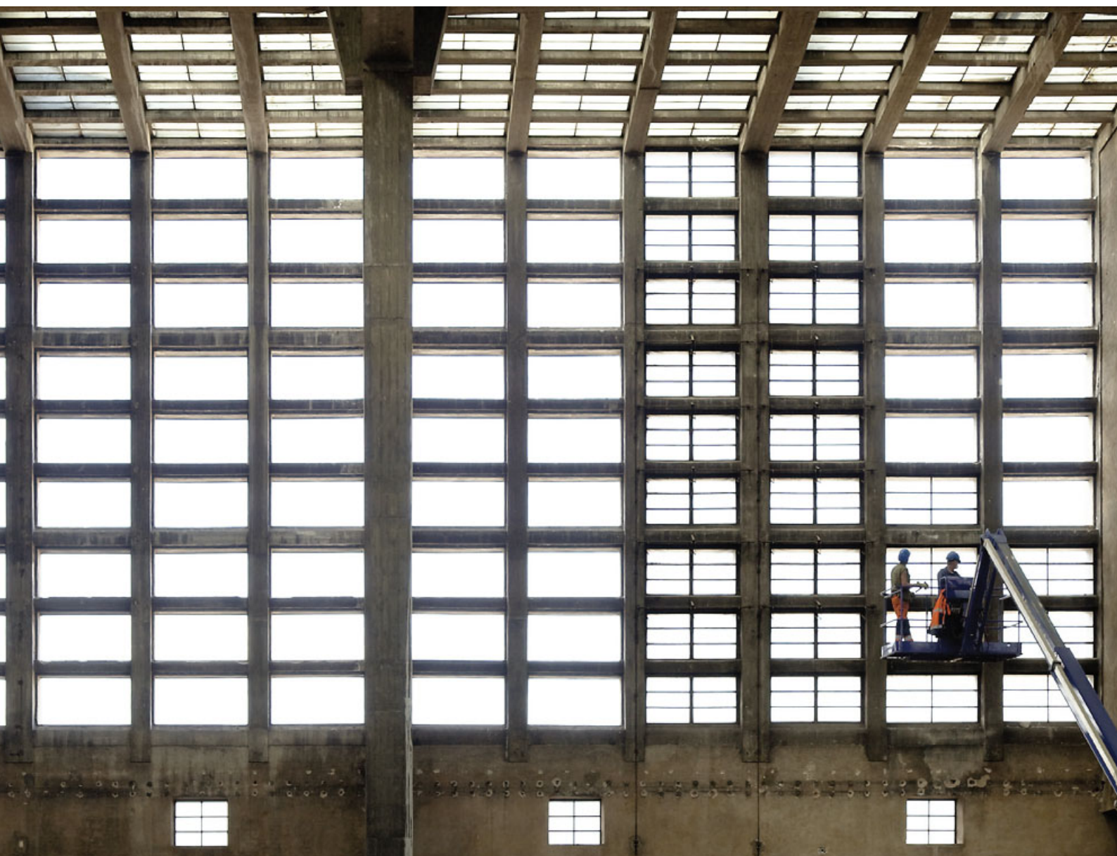
A Nagyvásárcsarnok betonrácsos homlokzata belülről. A csarnok restaurálása az építkezés egyik fontos eleme. Az épület külleme alapvetően megmarad, a homlokzatot és a felületeket a műemlékvédelmi szabályokkal összhangban állítják helyre.
