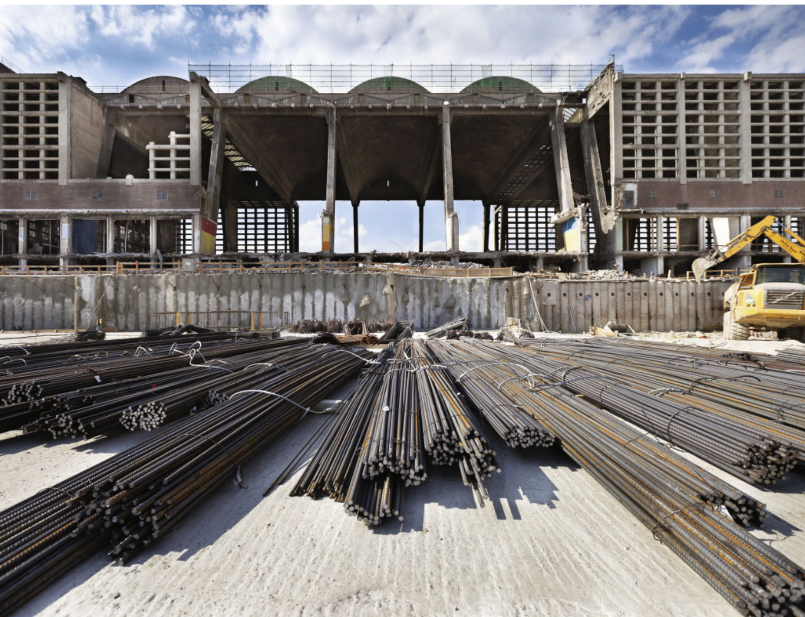
A kettős irodatorony alapja három méter vastag. A betonba mintegy 4200 tonna acélrudat helyeztek el.
