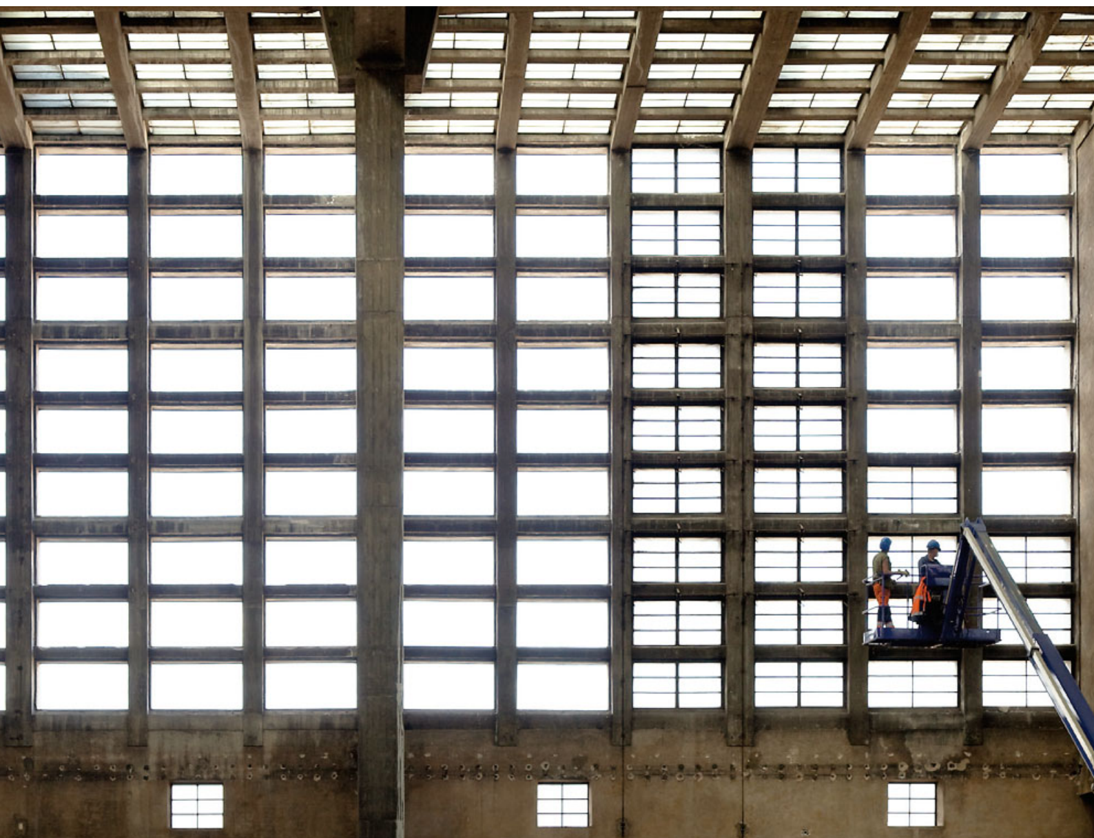
Binnenaanzicht van de Großmarkthalle: gevel met betonrasters. De restauratie van de Großmarkthalle is een belangrijk onderdeel van de bouwwerkzaamheden. De gevels en andere oppervlakken worden overeenkomstig de monumentvergunning gerestaureerd, waarbij het wezenlijke aanzien van het gebouw behouden blijft.
