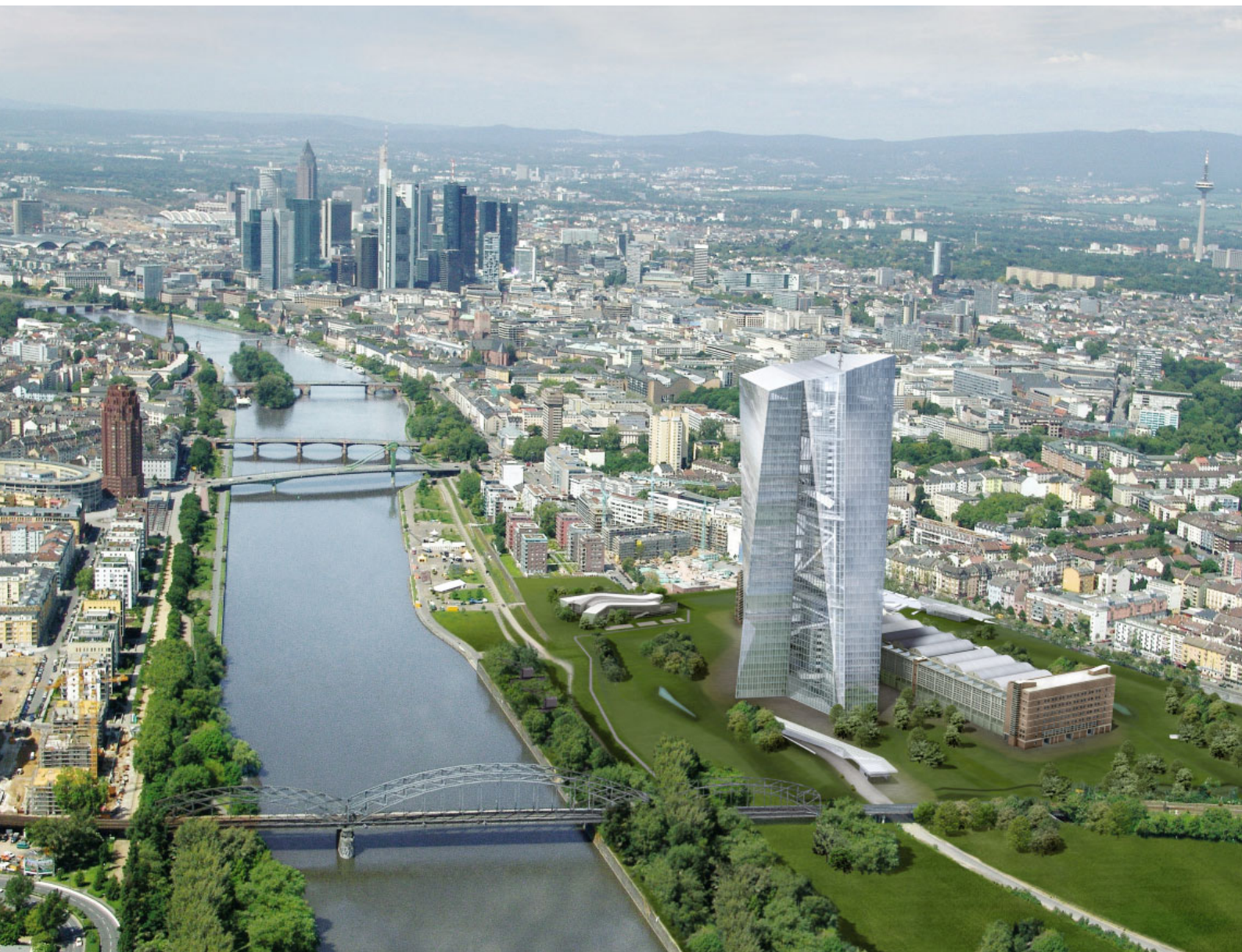
Het nieuwe ECB-gebouw gezien vanuit het oosten, met op de achtergrond het centrum van Frankfurt am Main.
