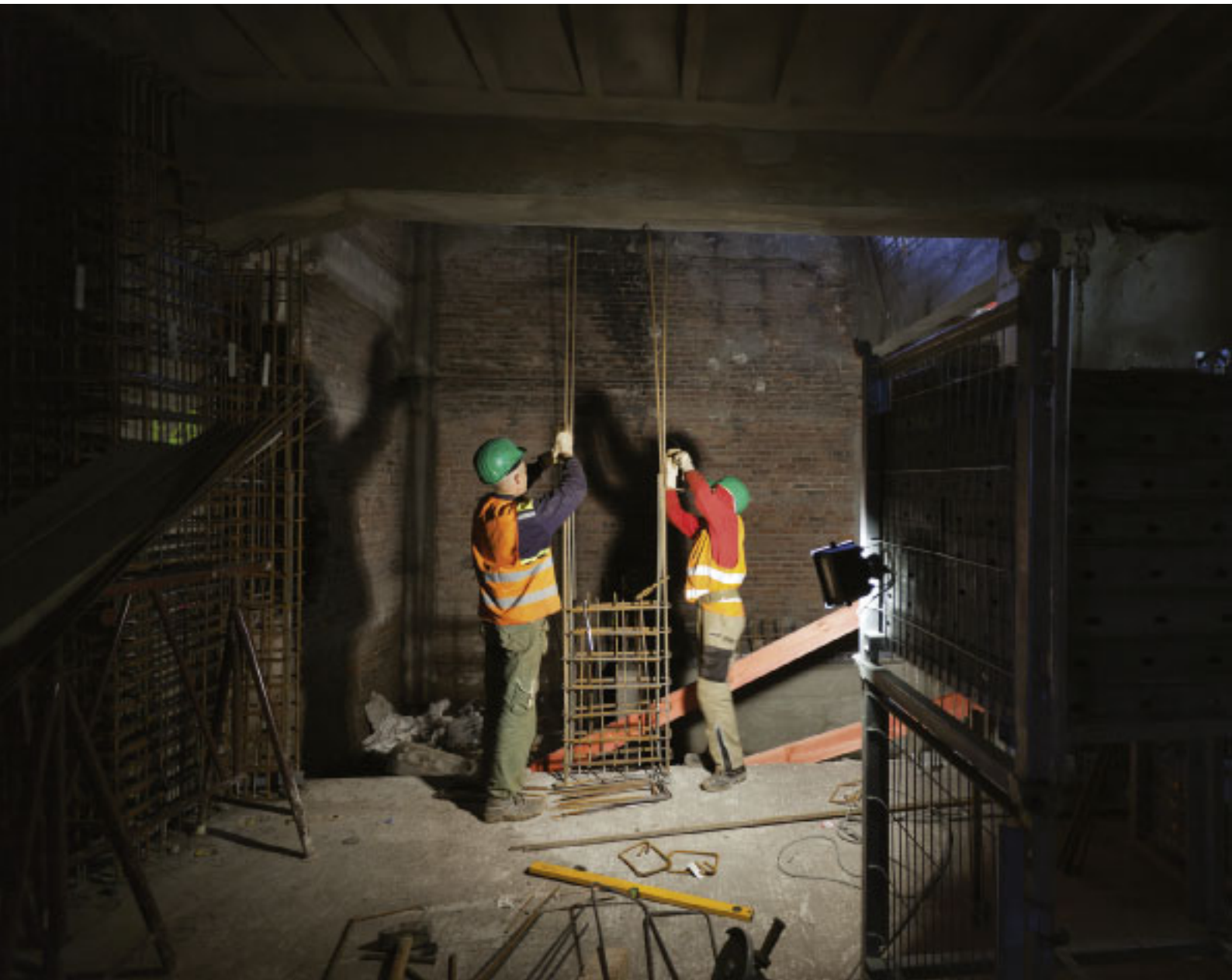
Trwają prace budowlane we wschodnim skrzydle Grossmarkthalle. Dawna hala targowa stanowić będzie integralną część nowej siedziby EBC. W tym celu wiosną 2010 r. rozpoczęto prace budowlane i renowacyjne.
