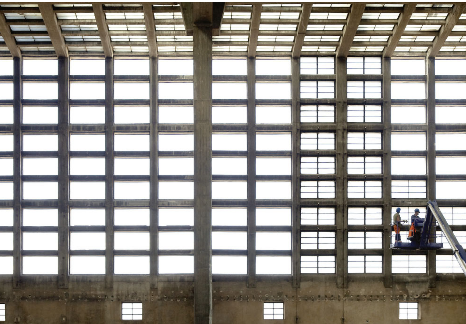
Betonowa krata tworząca elewację Grossmarkthalle, widok z wnętrza hali. Renowacja Grossmarkthalle stanowi ważny element prac budowlanych. Zachowany zostanie pierwotny wygląd budynku, a elewacje i ściany będą odrestaurowane zgodnie z zaleceniami urzędu ochrony zabytków.
