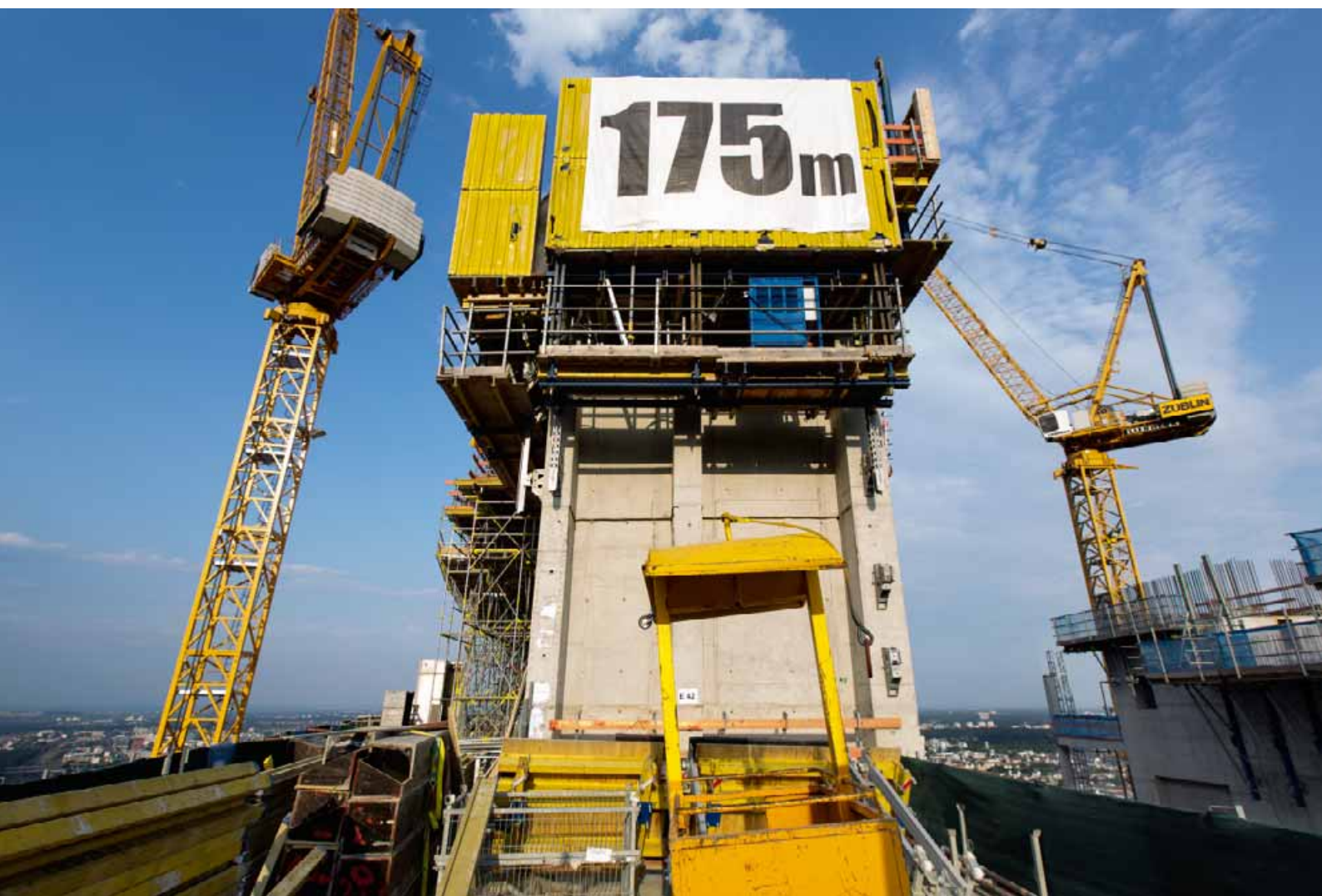
W lipcu 2012 r. dwuwieżowy biurowiec osiągnął wysokość 175 m. Od wschodniej strony trwa budowa szkieletu atrium, które następnie zostanie przeszklone.
