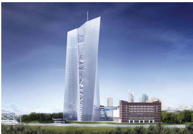
Abbildung: Ansicht des EZB-Neubaus von Osten. Die Bauarbeiten sollen 2014 abgeschlossen werden.
