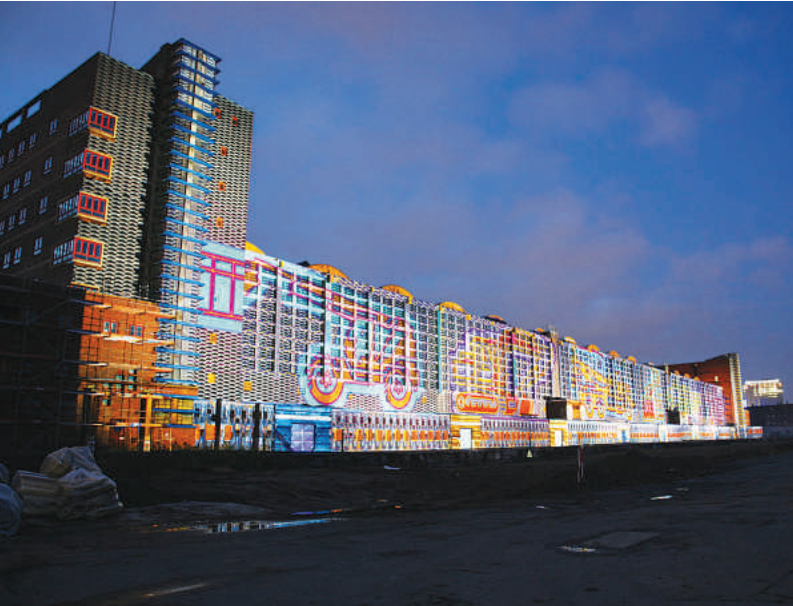
I forbindelse med Luminale 2008 lavede kunstnerduoen Casa Magica en lysinstallation på Grossmarkthalle. Her vises det andet af tre motiver. Det hentyder til de forestående arbejder med ECBs nye hovedsæde.
