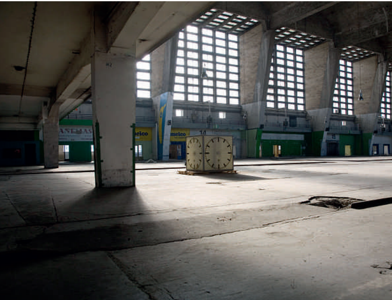
Et kig ind i den tidligere Grossmarkthalle, der nu er fredet (februar 2008). Arkitekten Martin Elsaessers gamle torvehal havde ved opførelsen i 1928 et større frit spænd end nogen anden bygning i armeret beton.
