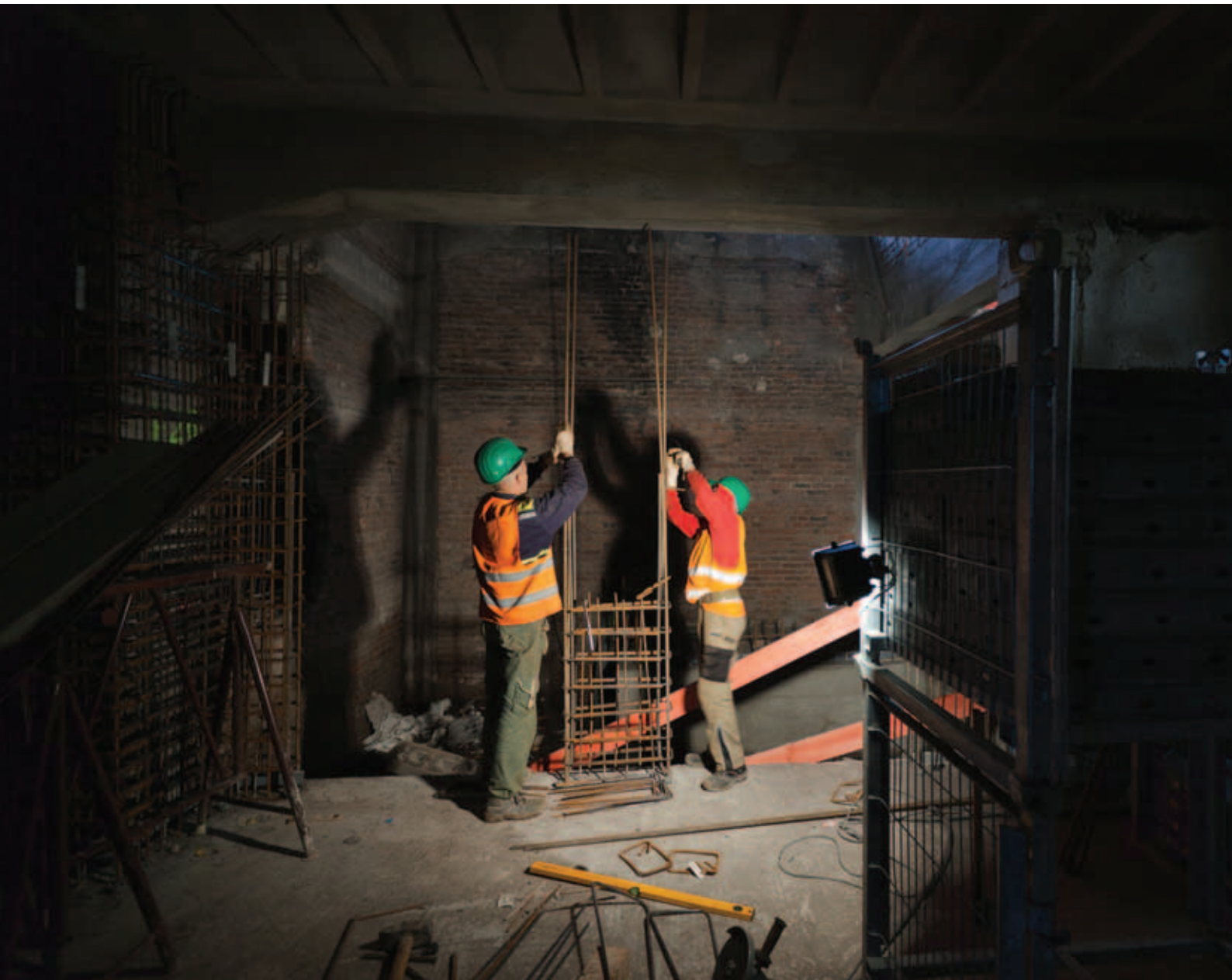
Byggeriet er i gang i østfløjen i Grossmarkthalle. Den tidligere torvehal bliver en integreret del af ECB's nye hovedsæde. Byggeriet og restaureringen blev påbegyndt i foråret 2010.
