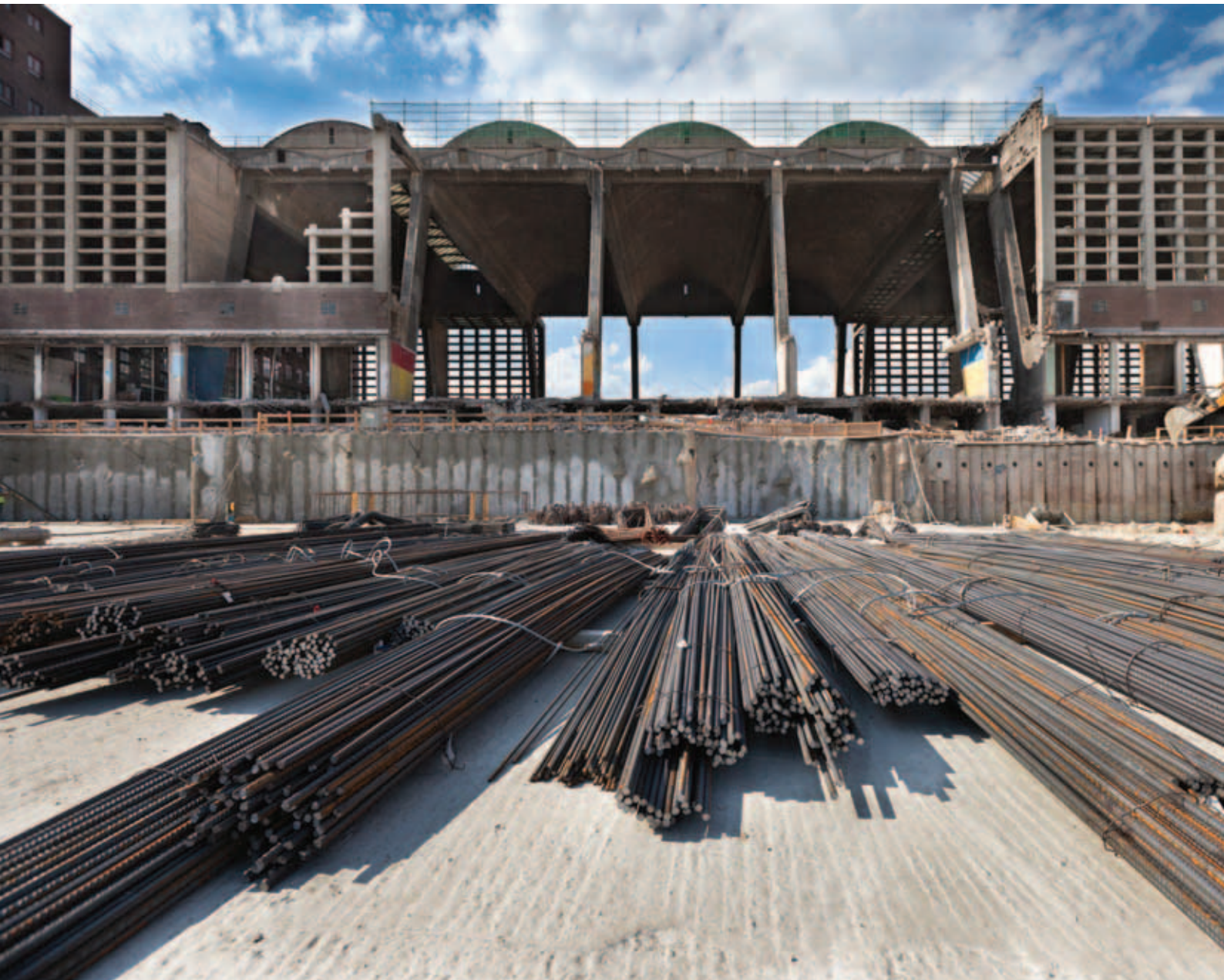
Fundamentspladen til det dobbelte kontortårn er omkring tre meter tyk. Der skulle bruges ca. 4.200 ton stål til armering af betonen.
