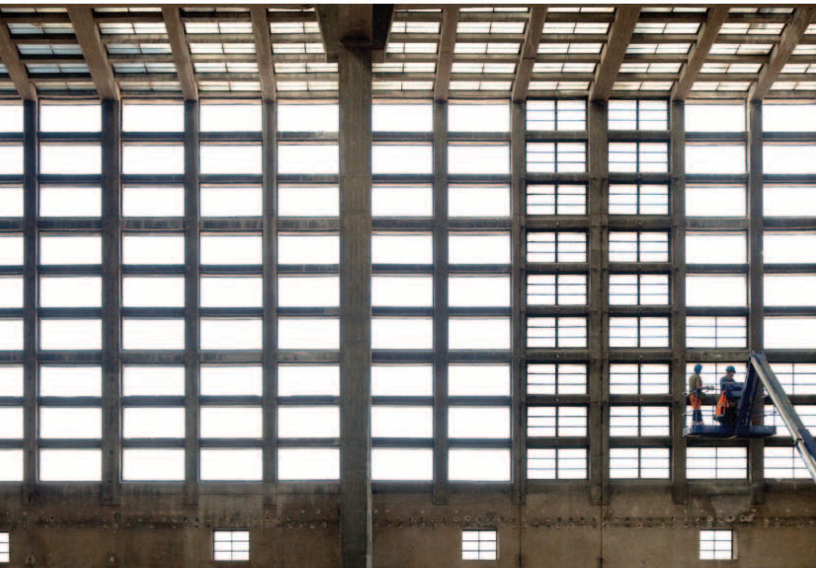
Gitterfacaden af beton i Grossmarkthalle set indefra. Restaureringen af Grossmarkthalle er et vigtigt aspekt i byggeriet. Bygningens grundlæggende udseende bliver bevaret, idet facader og overflader restaureres i henhold til fredningsdeklarationen.
