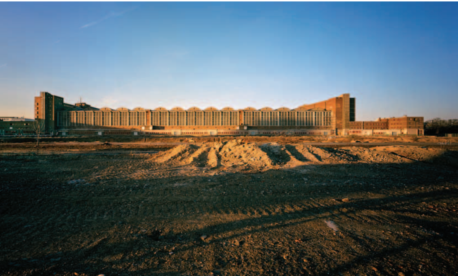
Grossmarkthalle set fra syd inden påbegyndelsen af de største anlægsarbejder. Grossmarkthalle er en fredet bygning, der tidligere husede Frankfurts engrosmarked for frugt og grønt. Den blev opført mellem 1926 og 1928 og er tegnet af professor Martin Elsässer.
