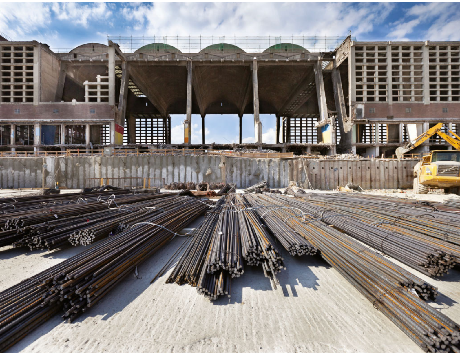
Dubultā biroju torņa pamata plāksnes biezums ir aptuveni trīs metri. Betona stiegrošanai bija nepieciešamas aptuveni 4 200 tonnas tērauda.
