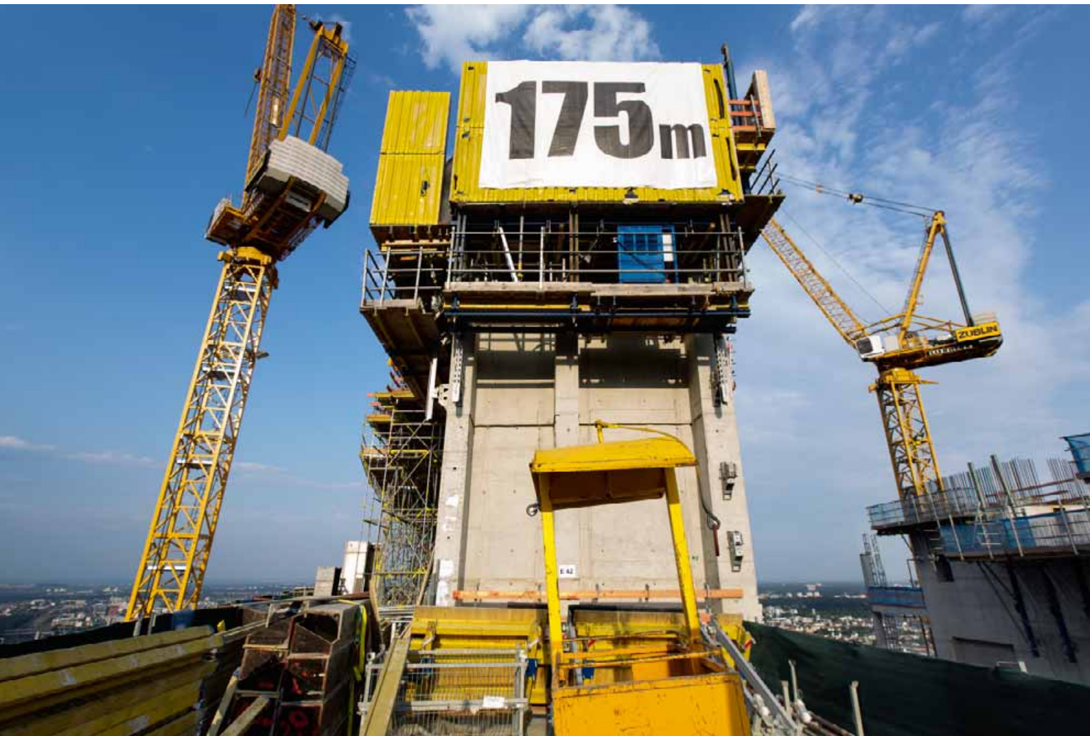
Der Doppel-Büroturm erreichte im Juli 2012 eine Höhe von 175 Metern. An der Ostfassade wurde der Bau der Rahmenkonstruktion für die Verglasung des Atriums in Angriff genommen.
