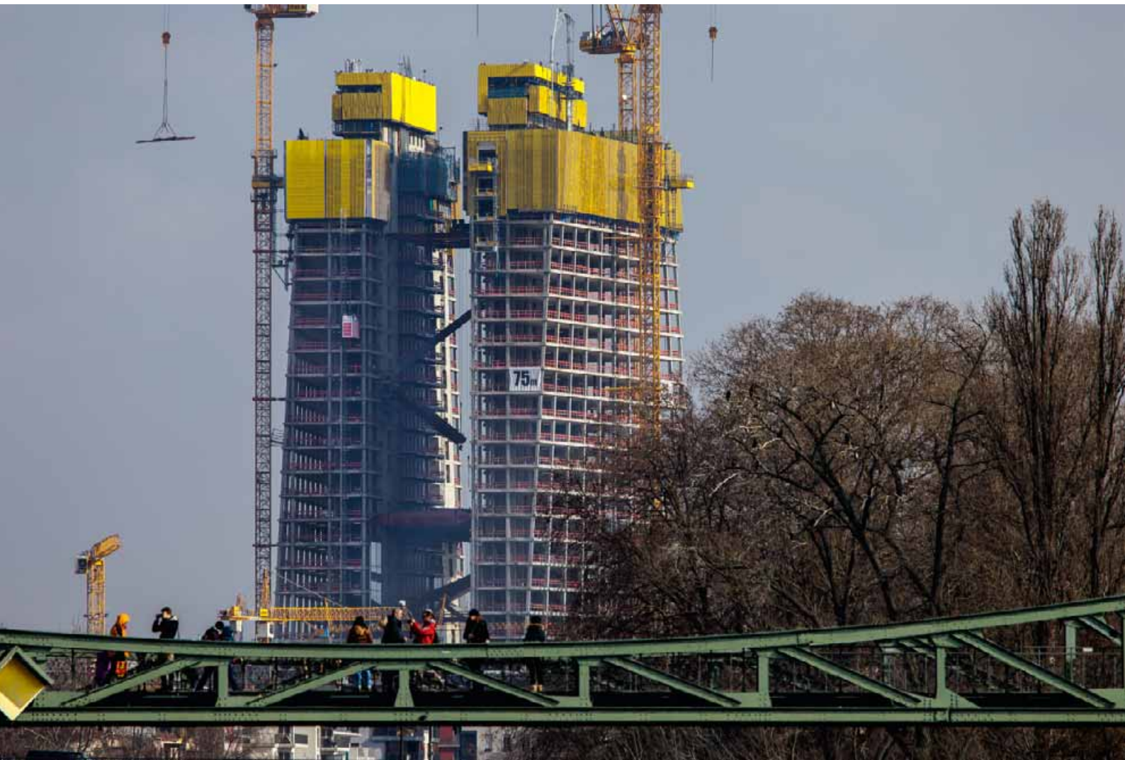
Im Jahr 2012 nahm der EZB-Neubau als neue und deutlich sichtbare Ergänzung der Frankfurter Skyline allmählich Gestalt an. Das Hochhaus wuchs – etwas schneller als erwartet – rund alle sechs Tage um ein Stockwerk.
