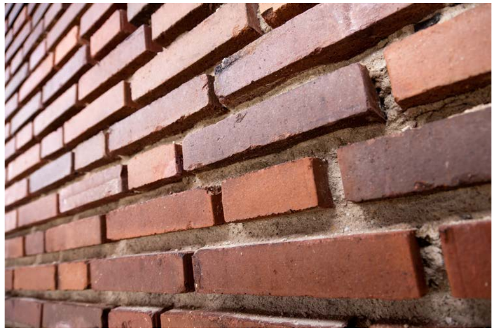
Abbildung 4 73 km restaurierte Fugen
