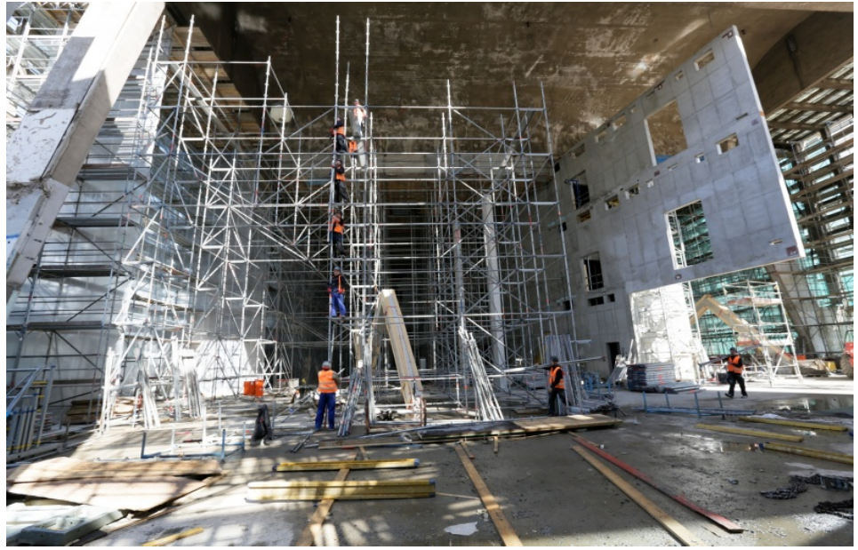
Abbildung 71 Sanierung der Dachschaalen
