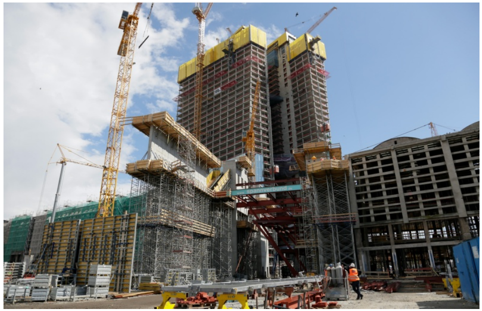
Rohbau „Haus im Haus“
