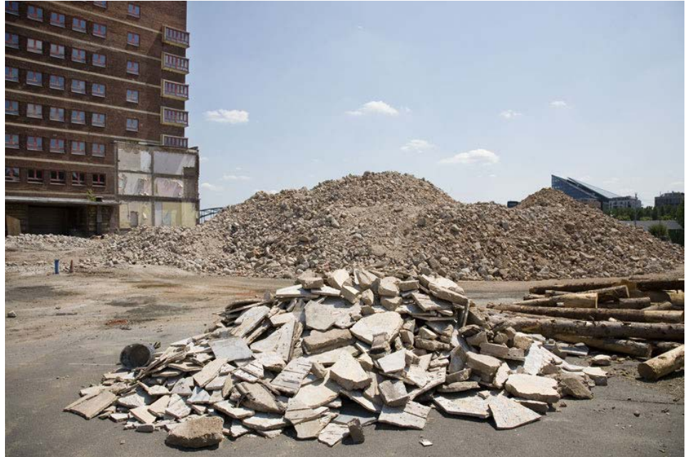
Figuur 61 De bakstenen van het westelijk bijgebouw worden met de hand verwijderd
